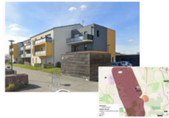
« Lot Mouton Blanc » à Pont-Réan (35) : résidence construite en 2015 et exposée à un risque « fort » de retrait-gonflement des sols.
